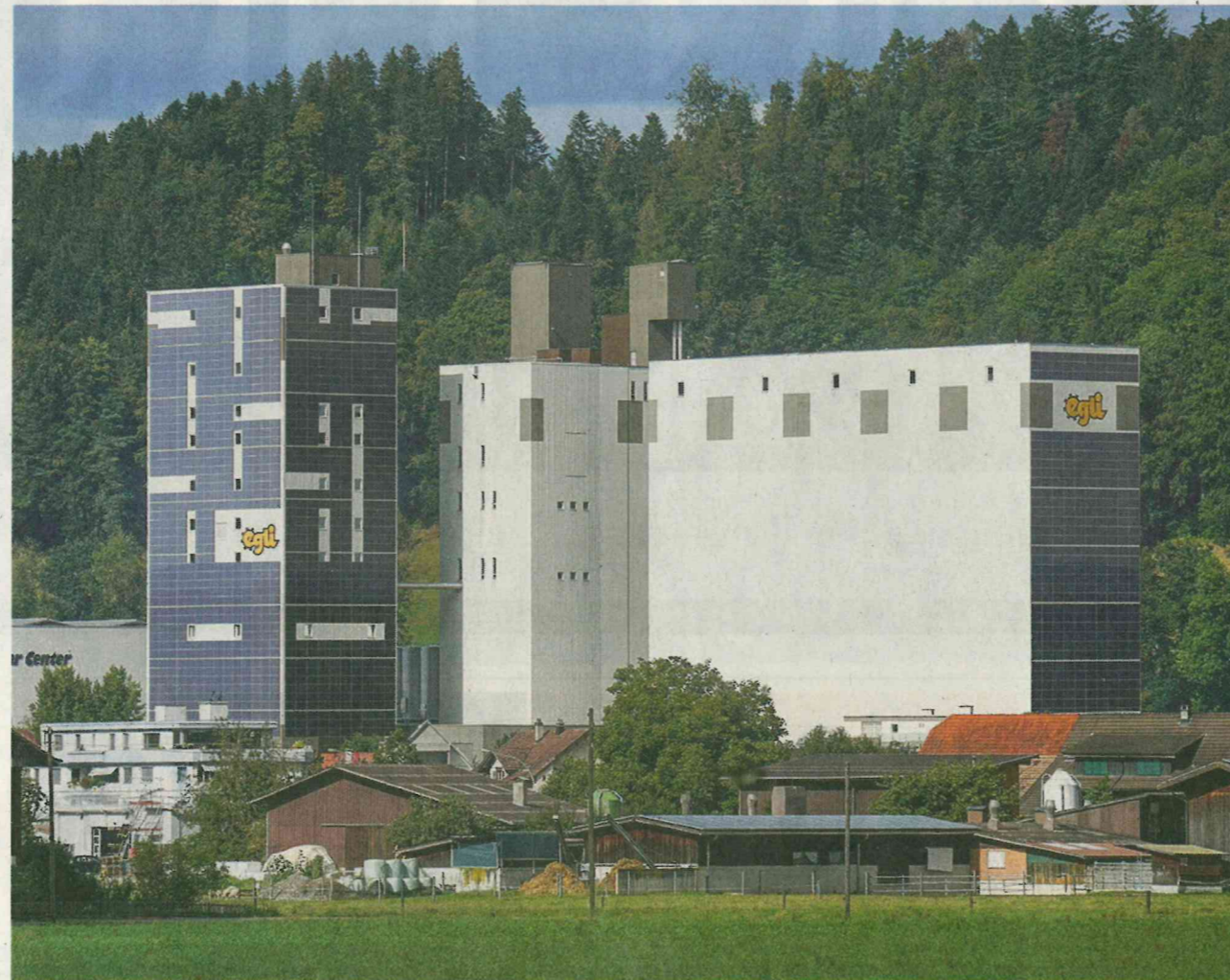
Solaranlagen auf Dächern gehören heute zum normalen Dorfbild. Als erste Futtermühle der Zentralschweiz will die Nebiker Egli-Mühlen AG nun drei Fassaden ihrer heutigen Silos mit Panels ausrüsten und so jährlich 530 000 Kilowattstunden Solarstrom für die eigene Produktion gewinnen. Visualisierung zvg
